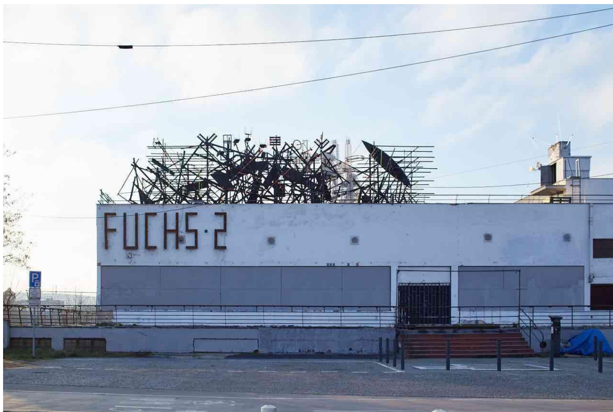
Instalace na střeše budovy (credits: Ureš)
